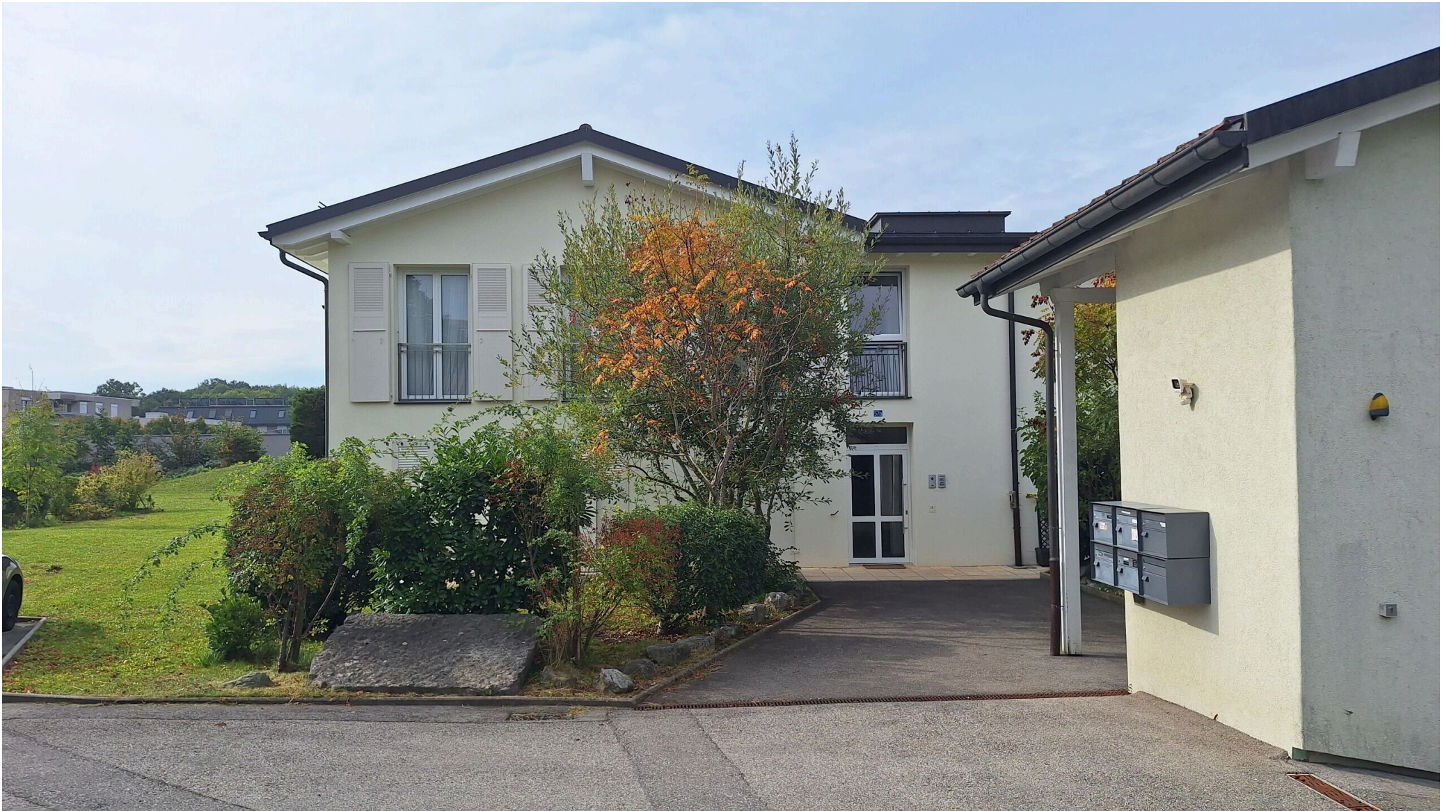
Immosol | Le Mont Clochette 57a | Immeuble Entrée
